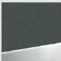
Trittschutz in Edelstahl, flächenbündig eingelassen
