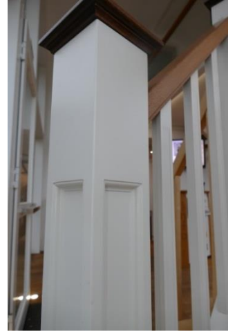
Pfosten mit eingrästeter Tasche und profilierter Kappe:
