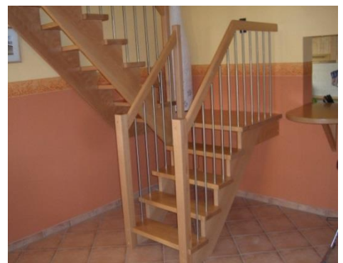
Treppenkonstruktion auf engstem Raum
